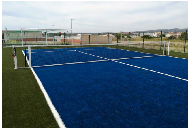
Pose d'un gazon synthétique sur couche de souplesse Gigan (Hérault)
