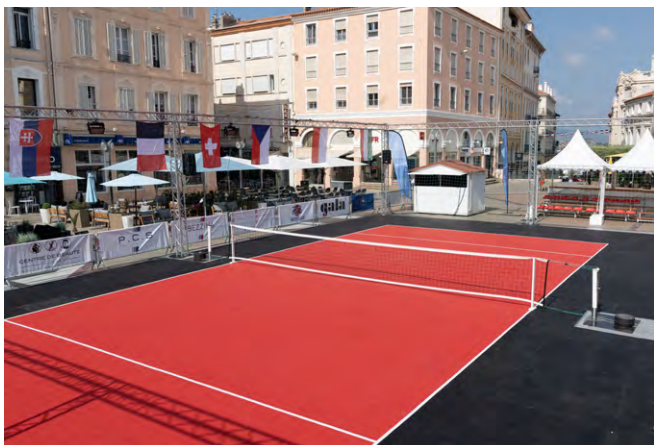
Dalles flottantes en thermoplastique Saint-Raphaël (Var)
