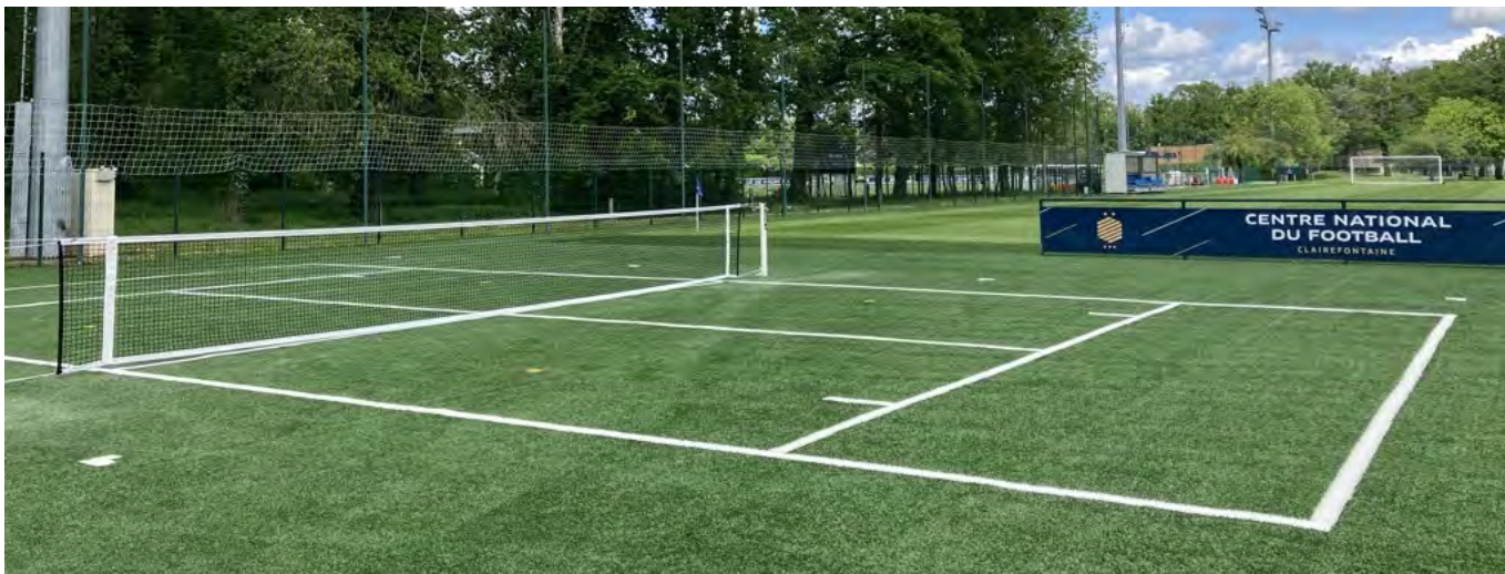
Pose par incrustation sur un terrain en gazon synthétique existant Clairefontaine (Yvelines)
